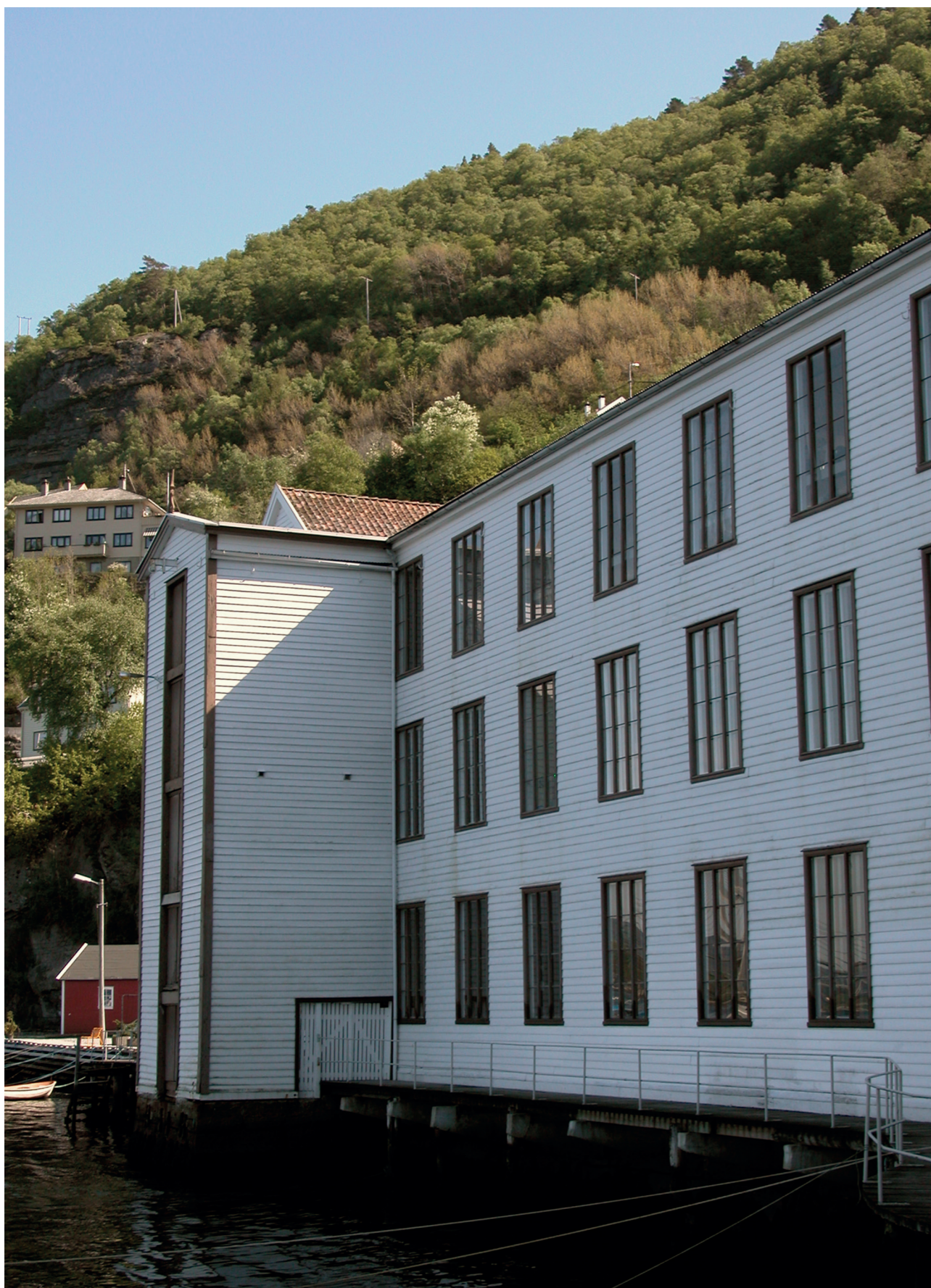
Fra 2020 vil antall fredede bygninger i museenes eie i Hordaland øke fra 134 til 172. Da blir hele anlegget etter Salhus Tricotagefabrik med 37 enkeltbygninger fredet. Her fra garnlageret og fabrikkbygg fra 1910.
