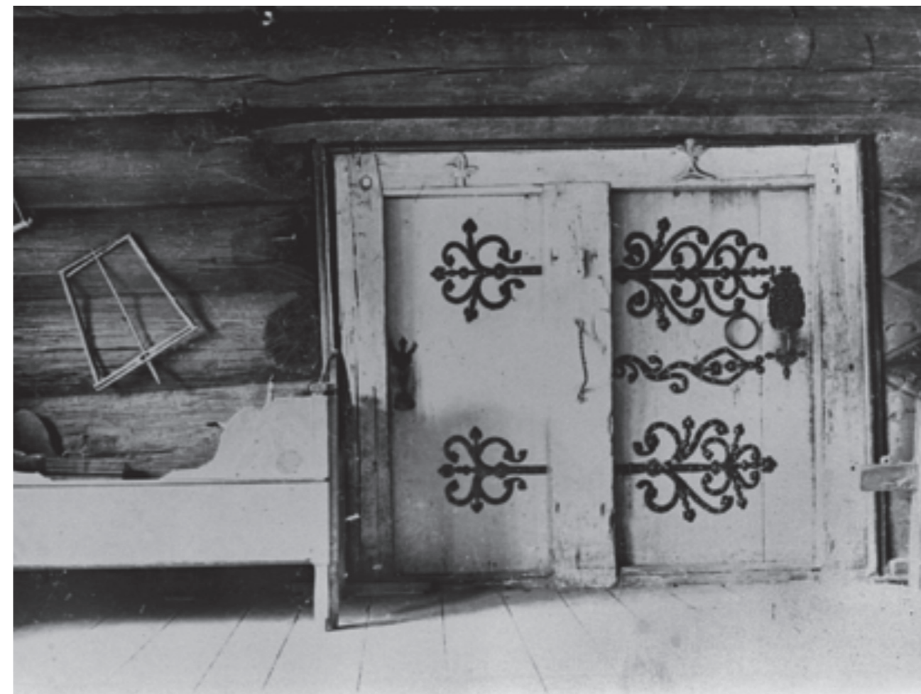
Historisk foto fra Lagmannsstova på Agatunet. Lagmannsstova er fra mellom 1220–1230 og er dermed en av de eldste stående profane trebygninger i Norge. Sammen med klosterruinene på Halsnøy er dette de eldste bygningene som forvaltes av museene i Hordaland. Veggene vi ser på bildet er laftet av ovalteljet tømmer.
