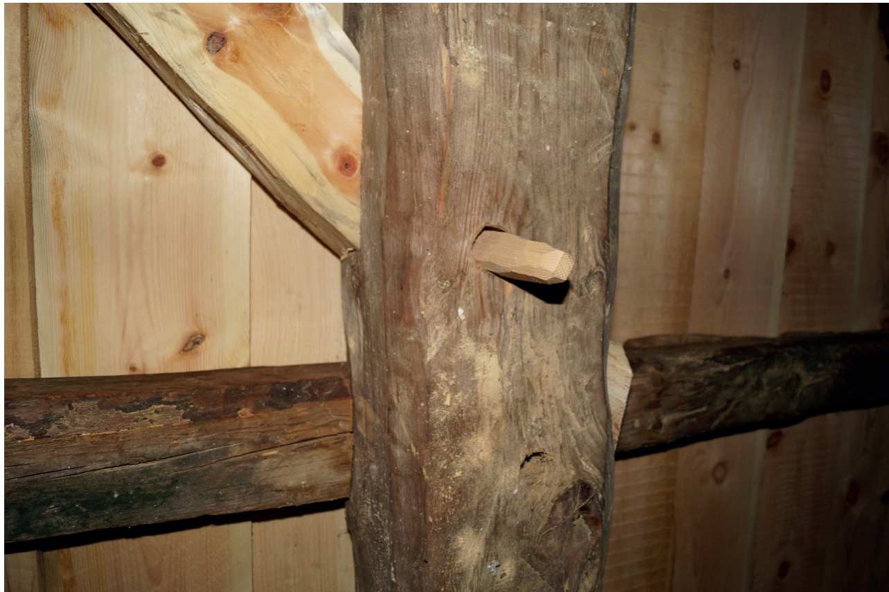
Nye og gamle bygningsdeler. Fra istandsetting av husmannsplassen Skarebakken ved Hardanger Folkemuseum, Utne, en del av det konsoliderte museet Hardanger og Voss museum.
