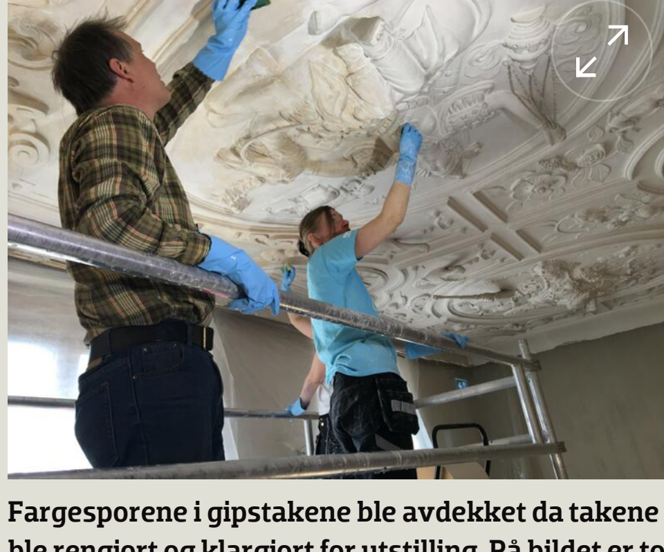
Fargesporene i gipstakene ble avdekket da takene ble rengjort og klargjort for utstilling. På bildet er to av museets objektkonservatorer i gang med å rense «De fire verdensdeler» fra 1662. Foto: Cecilie Thue / Norsk Folkemuseum
