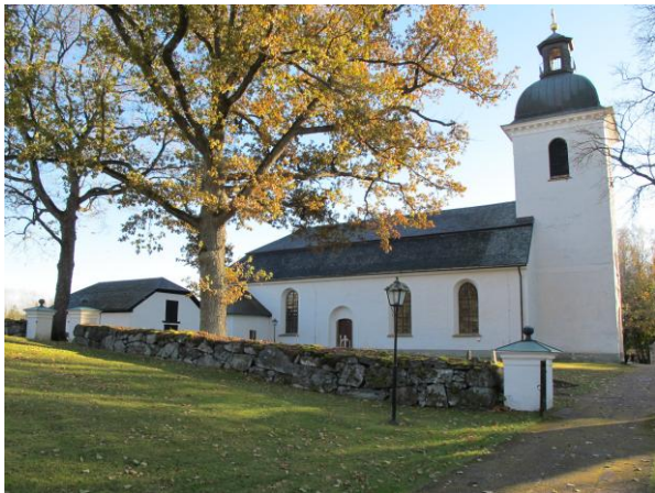
Lillkyrka kyrka med sockenmagasinet längst till vänster i bild samt de båda norra entréerna till kyrkogården, med putsade grindstolpar.
