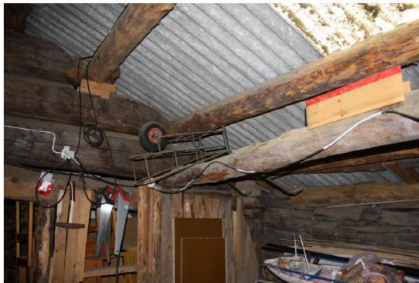
Dette delingsrøste er seget ned ca 12 cm på vestveggen. Dette skyldes råte i raftstokk samt første røstkubbe.
