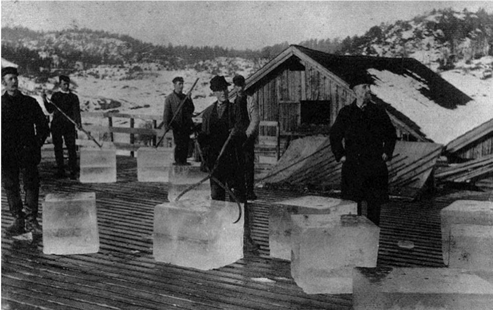
*Eisblöcke vor der Verladung in der Nähe von Kragerø (ca. 1900). Der Transport der Blöcke erfolgte mittels eines ausgeklügelten Systems von Gleitbahnen, so dass ein manuelles Heben der Blöcke weitgehend vermieden wurde. Dennoch gab es spezialisierte Greifzangen und Eishaken, die sowohl für den Transport an Land wie auch zum Stauen an Bord der Schiffe genutzt wurden. (Sammlung des Berg-Kragerø Museum, Kragerø)*
