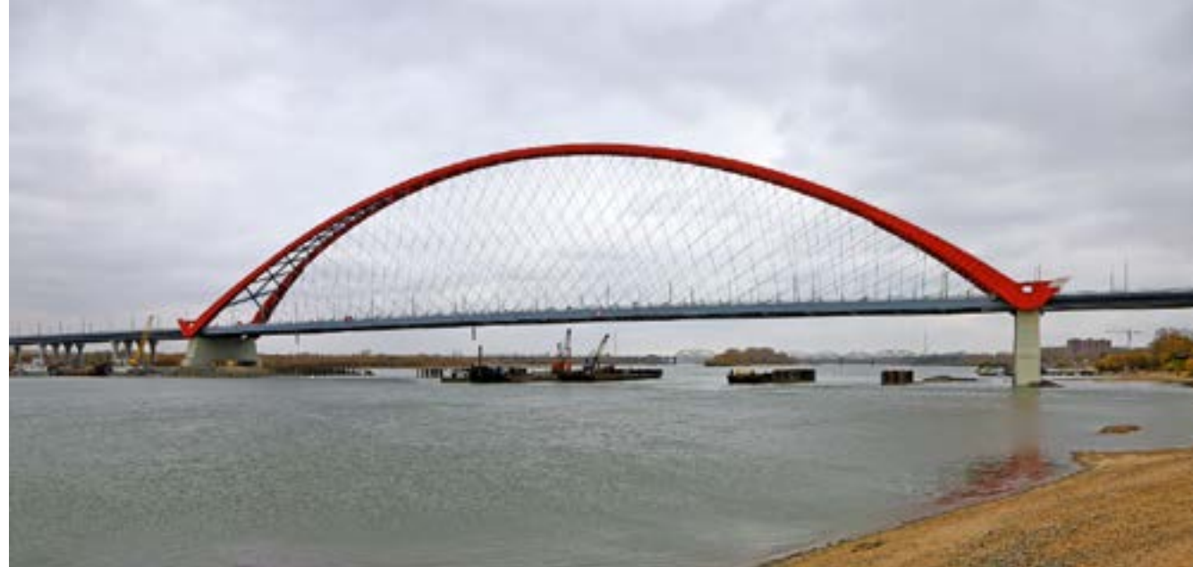
Bugrinsky Bru i Sibir fra 2010 er den lengste nettverksbogen i verda med eit spenn på 380 meter. (Foto via megaconstruccion.es.net)
