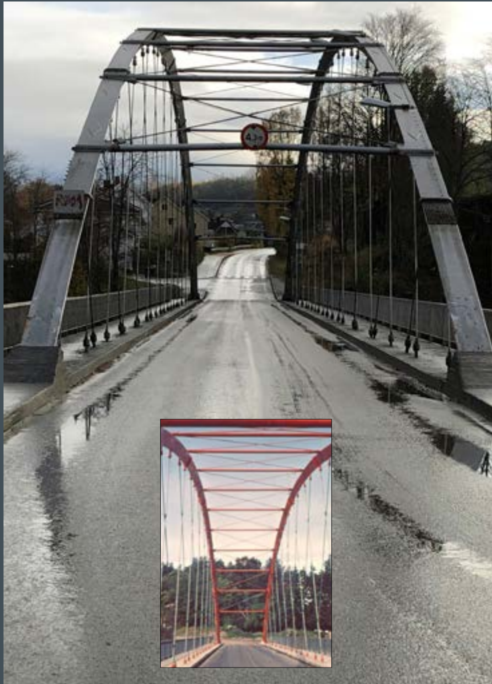
Den fyrste nettverkboegebrua i Norge vart bygd på Steinkjer i 1963. Her er Hakkadalsbrua slik ho er no (Foto: Bjørn Ivar Isachsen), og da ho var raud (Foto: Per Tveit)
