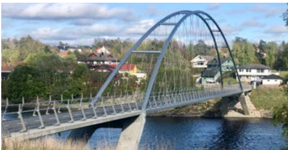
Den nyeste gang/sykkelvegbrua utforma som nettverksboge er mellom Opsund og Hafslundsøy rett nord for Sarpsborg, opna 29. september 2017. (Foto: Håkon Aurlien)
