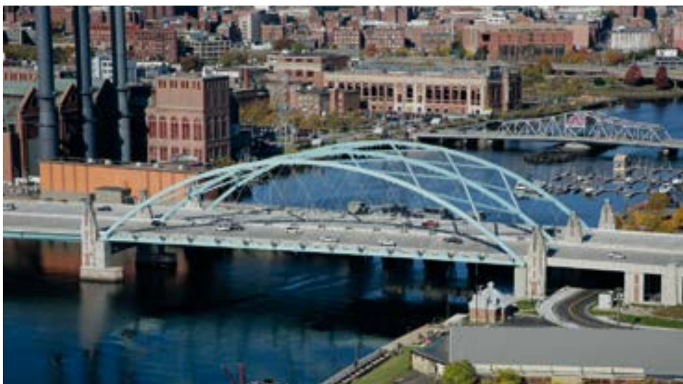
Den første nettverkbu som blei bygd i USA var The Providence River Bridge på Rhode Island frå 2007. Brua blei bygd på ei kai ca. 20 km fra brostaden og flytta på plass ved hjelp av pongtongar og tidevatn. (Foto: CDR Maguire)
