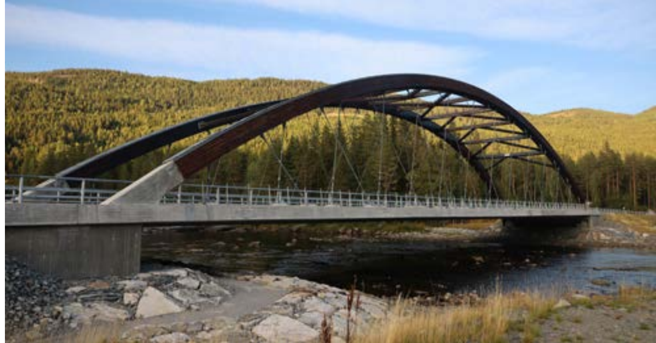
Hellefosbru i Aurdal, med spennvidde 70 meter, vart opna i 2019 til avlasting for den freda Lunde bru. Brua har tre i bogen, og betong i undergurten. (Foto: Håkon Aurlien)
