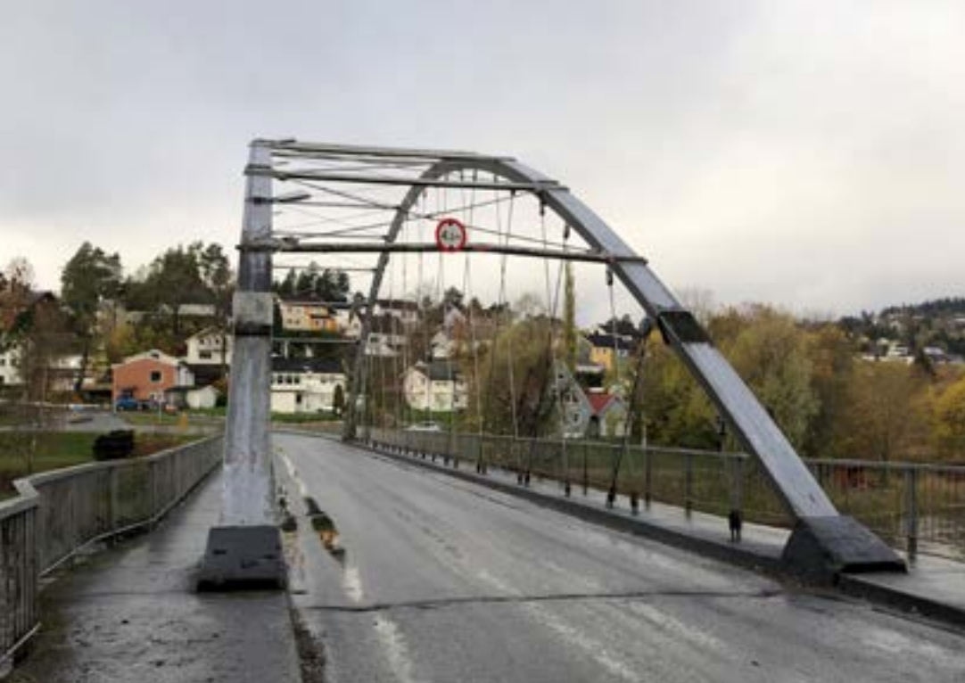
I 1963 blei det bestemt at Tveits nettverk-boge skulle byggast på Steinkjer i Nord-Trøndelag. Han fekk mykje hjelp og gode råd fra professor dr. Arne Selberg. Byingeniør Sigurd Balgaard var for å bruke nye lovande ideer. Arkitekt Terje Moe gjorde brua vakrere. (Foto: Bjørn Ivar Isachsen)
