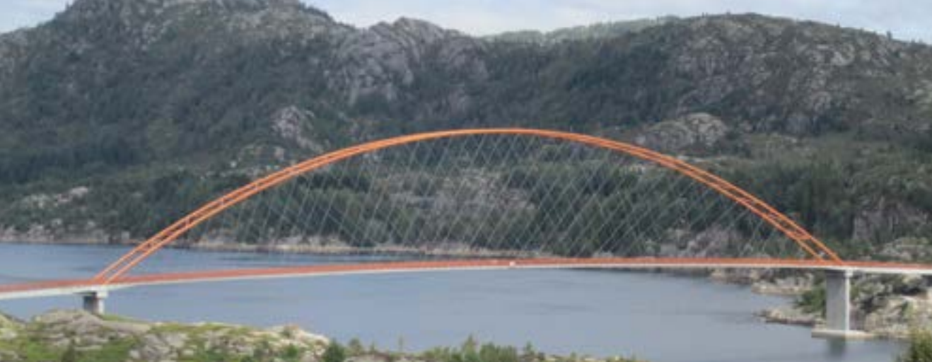
Brandangersundet bru ved utløpet av Sognefjorden er den slankaste bogebrua i verda. Ho har ei spennvidde på 220 meter og var laga i Tyskland. (Foto: Per Tveit)
