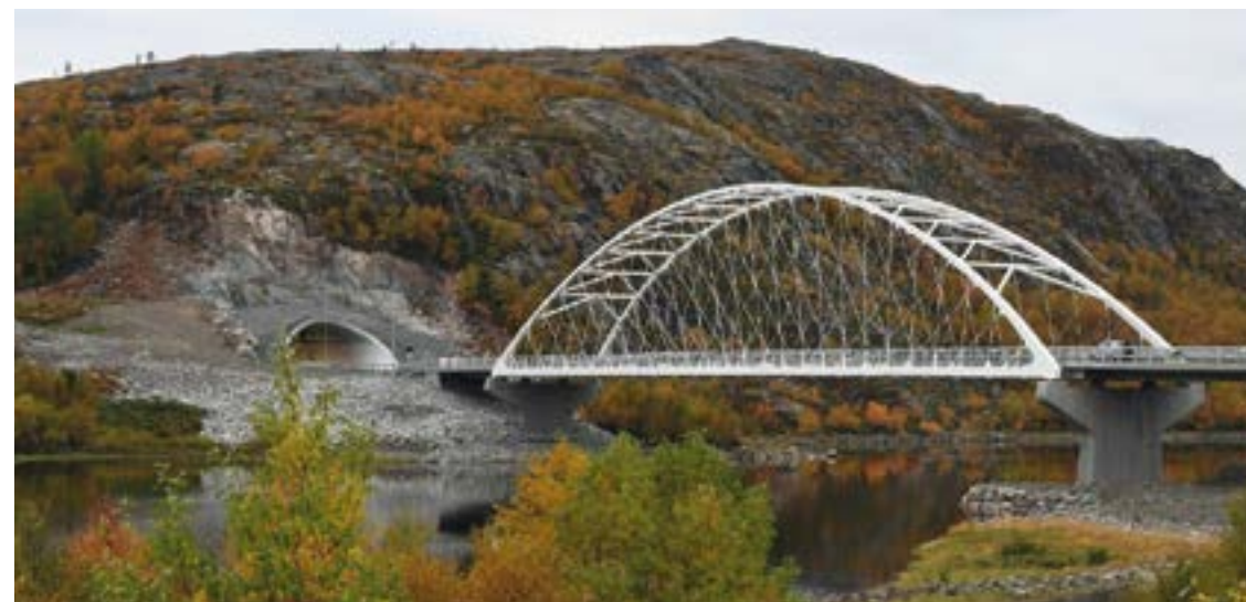
Bøkfjord Bru nær den russiske grensa, med spennvidde 120 meter, opna i september 2017. (Foto: Knut Opeide)
