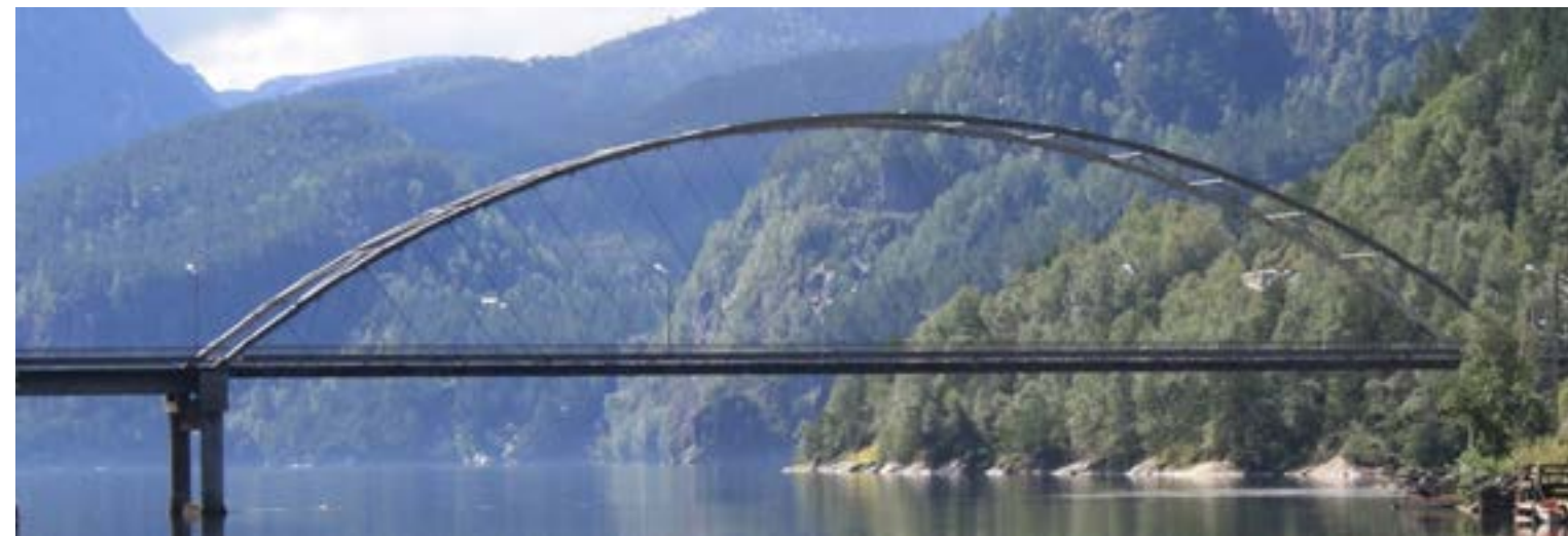
Brua over Bolstadstraumen, med spennvidde 84 m, opna i 1959. 5 (Foto: Per Tveit)
