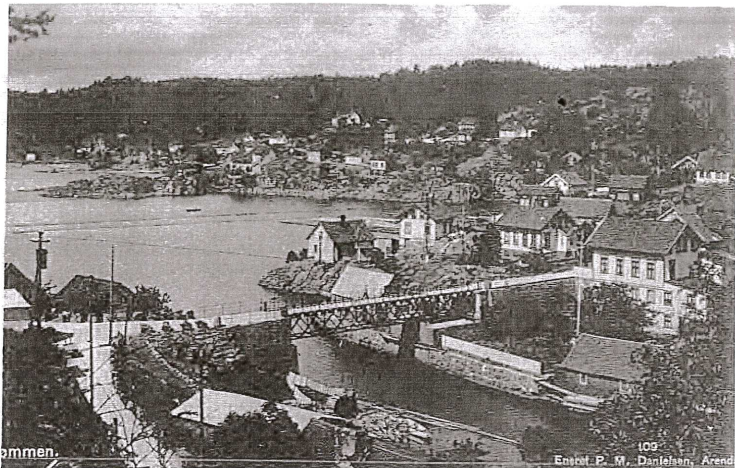
Strømmen bro, ferdig bygget i 1878, var den første fagverksbro i landet. Den hadde en spennvidde på 19,80 meter.
