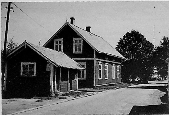
Lillesand stasjon sett fra sporsiden. Ved inngangen bak står et skilt med teksten: Informasjon til eiere av eldre hus.
