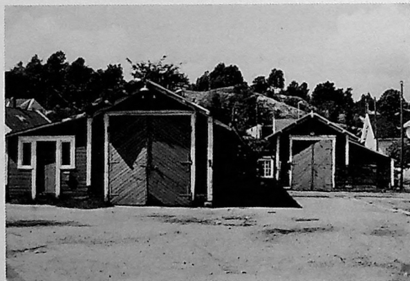
Lokstall og verksted i Lillesand - dessverre en del forfallent.
