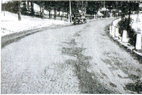
Fig. 1. Stensatt vägbana i stockholmstrakten efter tjällossningen, våren 1933.
