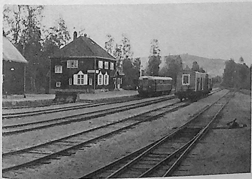
Stasjonsbygningen på Treungen er en staselig bygning.
