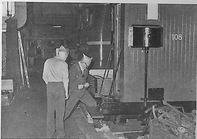
Harald Tyskerud og Einar Kåsine monterer beslag på overtid på verksted Grorud. Foto: Bjørn Solberg.
