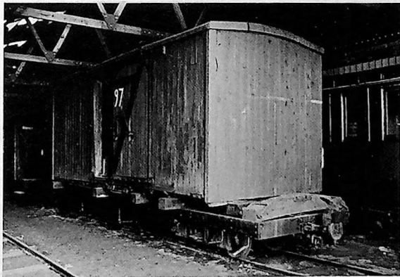
Løftekasse 97 har nå fått plass i vognhallen etter lok nr 8.
