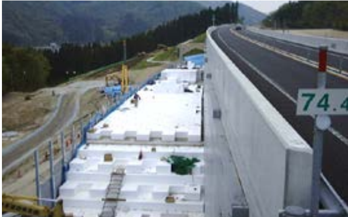
Breddeutvidelse av Yamagata Expressway, Japan, med vertikale sidevegger. (Foto fra EDO, Japan)
