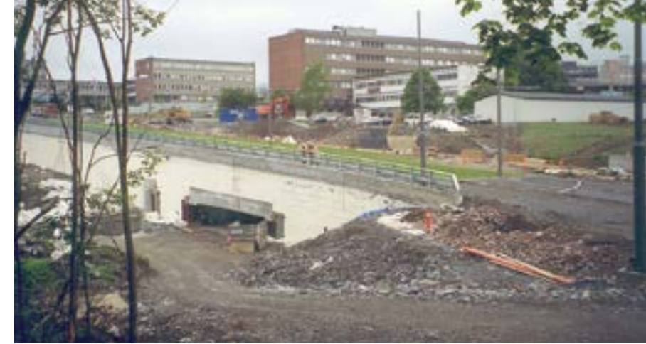
15.000 kubikkmeter EPS ble brukt i en kombinert fylling for trikke-trasé og veg foran Veglaboratoriet i Oslo. Veglaboratoriet opphørte ved omorganiseringen i 2003, og bygget er nå fjernet. (Foto: Roald Aabøe)
