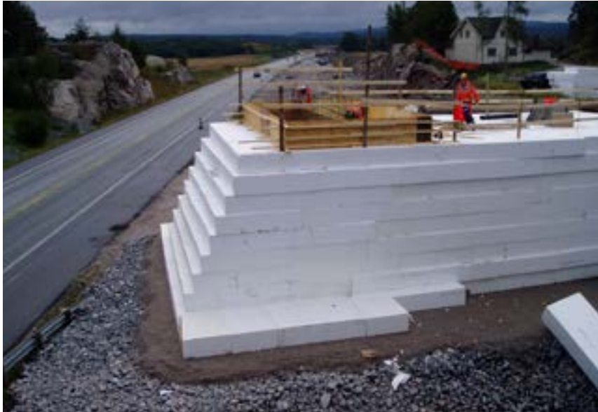
Fyllinger for interimsbro over E6 ved Gimsøyvegen. (Foto: Tor Helge Johansen)
