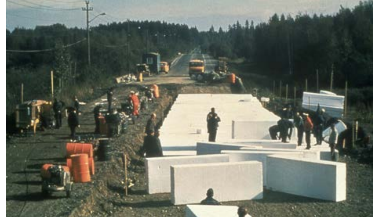
Det første laget av EPS-blokker er under utlegging på Flom broer i Akershus i 1972. (Foto: Svein Alfheim)
