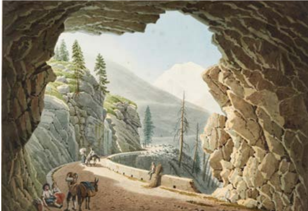
Fjellveien over Simplon-passet mellom Rhône-dalen i Sveits og Piemonte i Italia kan stå som eksempel på de nye franske fjellveiene. Mellom 1801 og 1805 ble arbeidet ledet av ingeniøren Nicolas Céard. Veien var omkring seks meter bred og bygd opp med ca. 30 cm tykt bærelag av knust stein og et vei-dekke av grov grus. Standard stigning var fem prosent og kurvene hadde romslig radius. Bilde av Galerie Schalbert fra boka «Picturesque tour from Geneva to Milan, by way of the Simplon» (1820) av F. Shoberl. Illustrert av Gabriel Lory. Fra British Library Mechanical Curator Collection.
