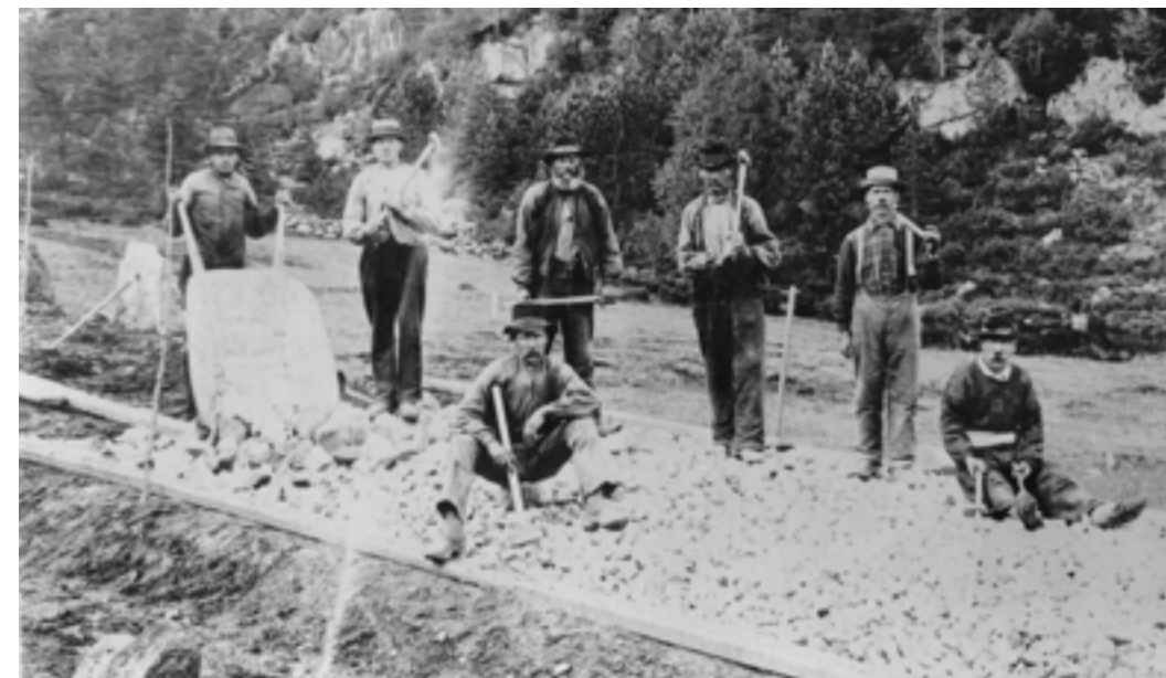
Håndpukking etter utlagt mal på fylkesvei 461 i Finstrand, Vest-Agder noen år før 1914. Var dette makadamisering? Bildet er fra Bjørn Olav Hansen som kommer fra en familie av veibyggere i Kvinesdal.
