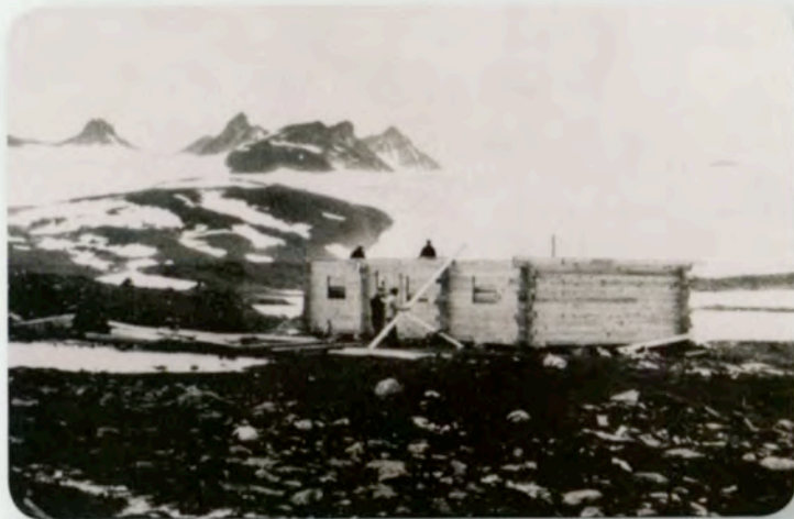
Reising eller nedtaking av en av to boligbrakker ved bygging av Sognefjellsvegen 1936-1939. Den er av samme type som Krossbubrakka på Vegmuseet, men det er usikkert om dette er denne. Foto: Jens Kjølén. Norsk vegmuseums fotoarkiv.
