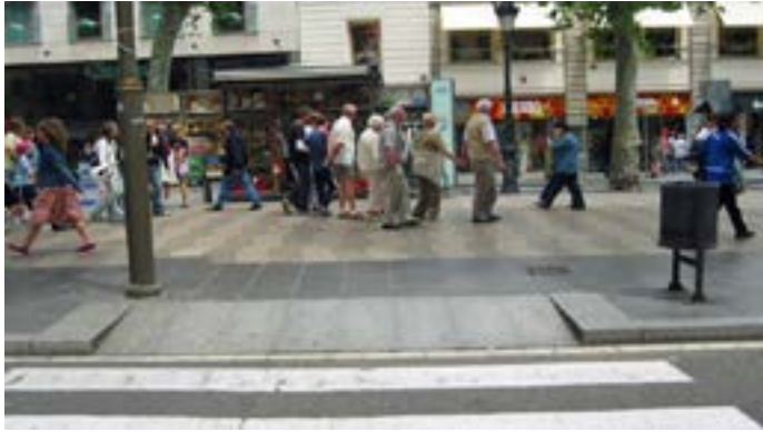
Spania var tidleg ute. Her nedsenka kantstein og tydeleg markering av gangfelt inntil La Rambla i Barcelona.
