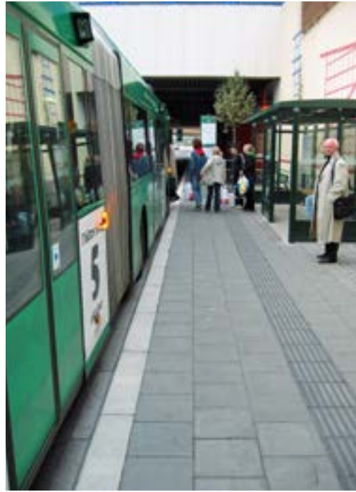
Svensk standard for gangfelt i Horngata i Stockholm. Busslomme med «Kesselstein» slik at bussen kjem godt inn til plattformen for å få trinnfri tilgjenge i Malmö (2004)
