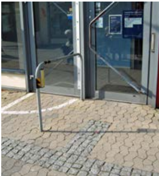
Trinnfri tilkomst og automatisk dørøpnar tilpassa rullestolbrukar i Helsingborg. Benk og trapp med riktig utforma handlistar i Helsingborg. (Alle foto: Bjørn Kåre Steinset)
