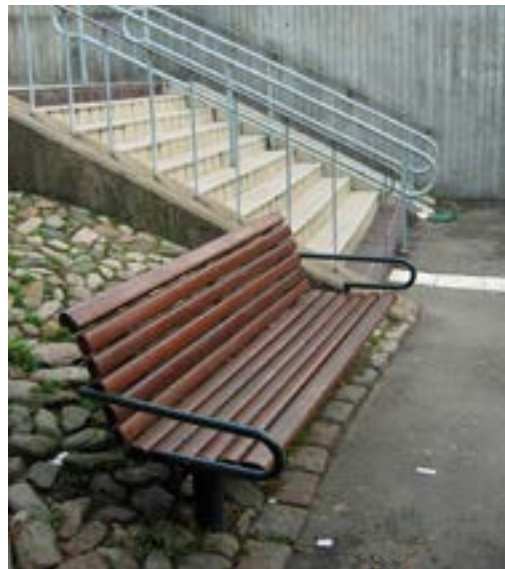
Trinnfri tilkomst og automatisk dørøpnar tilpassa rullestolbrukar i Helsingborg. Benk og trapp med riktig utforma handlistar i Helsingborg. (Alle foto: Bjørn Kåre Steinset)
