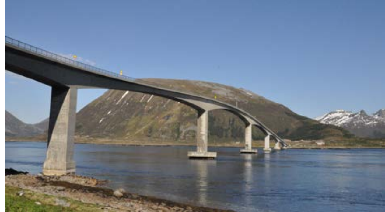
Gimsøystraumen bru i Lofoten er bygd i 1981, og er blant bruene som har fått katodisk beskyttelse mot armeringskorrosjon. Et forskningsprosjekt gikk fra 1991 til 1997 og ga mye lærdom om hvordan man skulle sikre lang levetid for 1970- og 1980-tallsbruene. (Foto: Håkon Aurlien)
