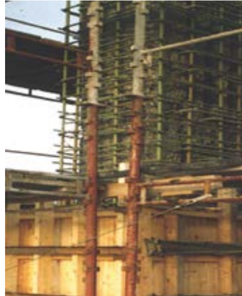
Nye armeringsregler resulterte i en tett armering som sammen med krav til tett betong skapte utfordringer ved støpearbeider. (Foto: Kjell Tore Fosså)
