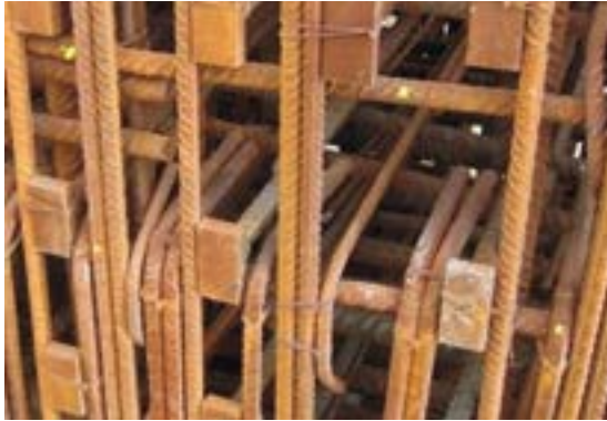
Nye armeringsregler resulterte i en tett armering som sammen med krav til tett betong skapte utfordringer ved støpearbeider. (Foto: Kjell Tore Fosså)
