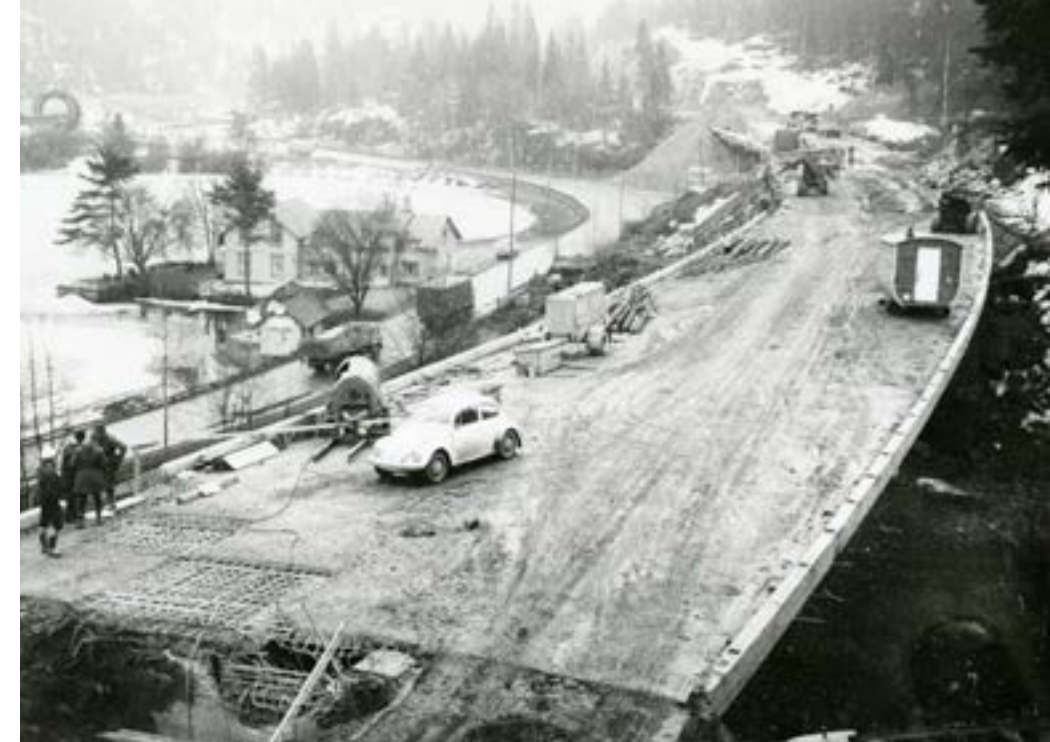
Her Lovise bru under bygging i april 1970. Vegen tok også E6-trafikken frem til Ringnestunnelen sto ferdig (utenfor billedkanten til venstre) i 1986.
