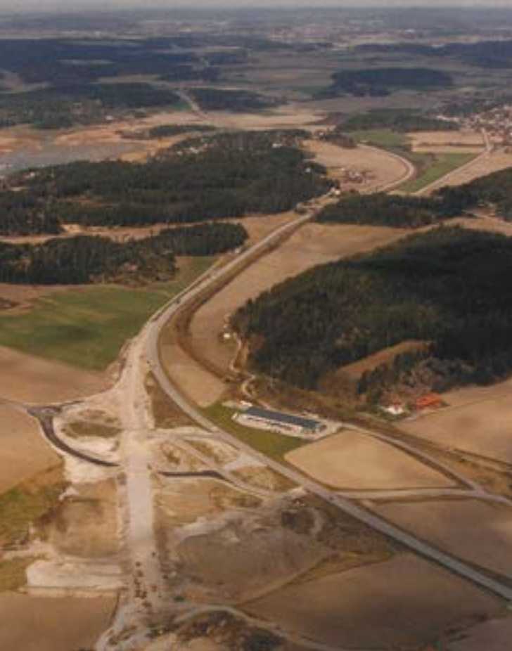
Fra Oslo til Svinesund ble E6 bygd ut etappevis, fra landevegsstandard til to-felts motorveg og så endelig møtefri firefeltsveg i 2008. Midt på 1980-tallet var tofeltsvegen kun bygd frem til Ingedal, og så ble det pause. Bildet her er fra Ingedal da anleggsarbeidene gikk videre i 1991. (Foto: Håkon Aurlien)
