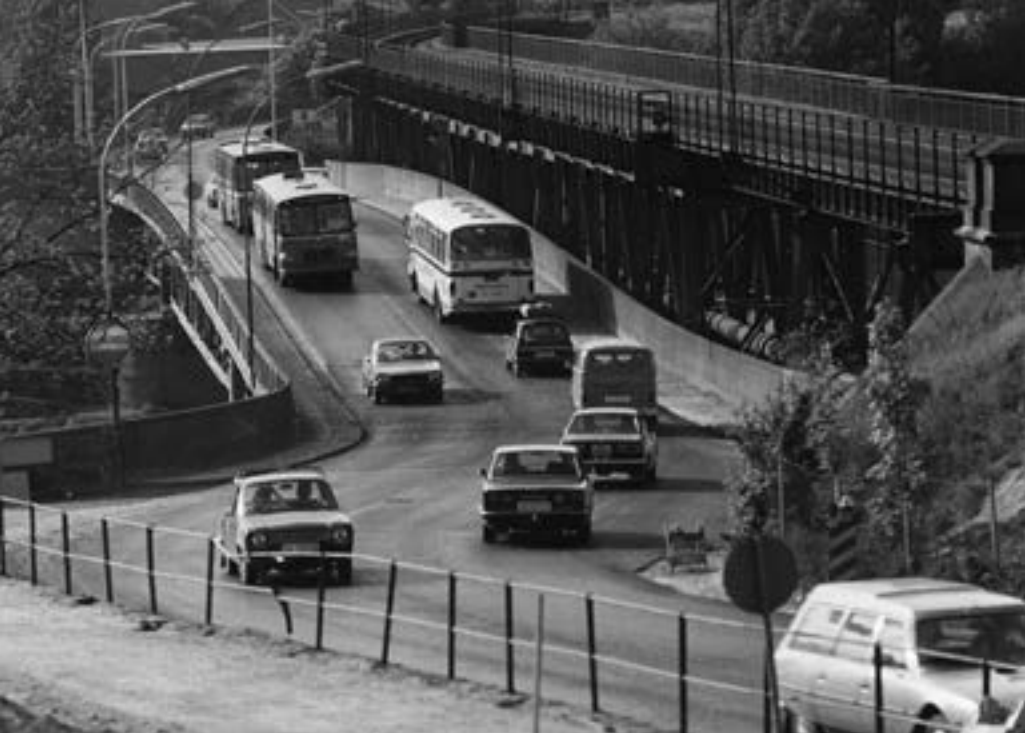
Helt til 1978 gikk E6-trafikken over Sarpebrua. Det resulterte i køer hver dag, sommerstid 7-8 kilometer lange. Fundamentene er fortsatt der fra den første kjørebrua over Glomma, konstruert av Norges første vegdirektør Christian Wilhelm Bergh og bygd i 1854, og bygd om til nåværende utseende i 1936. Bildet her er fra ca. 1975.
