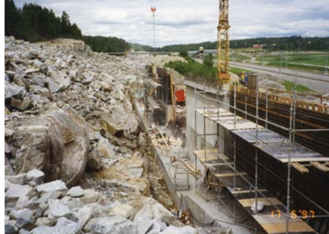
Akershus nådde i 1998 frem til Østfoldgrensen med firefelts motorveg uten å ty til bompenger. Her er Grimesund bru under bygging syd for Sonsveien stasjon i 1976. Ny E6 og jernbane ble bygd i et fellesprosjekt. Ny jernbane ble tatt i bruk i 1994 og ny E6 i 1998
