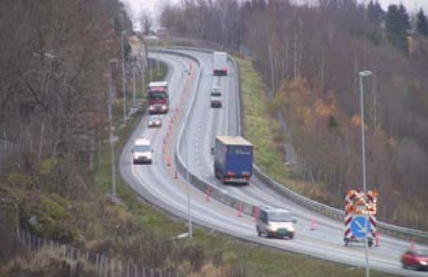
E6-strekningen fra Åsgård (Missingmyr) i Råde til Alvim i Sarpsborg ble på 90-tallet bygd ut fra landevegsstandard til tre-felts motorveg. Men da den var ferdig i 1996 var den allerede overbelastet. I påvente av firefeltsutbygging ble det behov for en midlertidig midtdeler i betong. Bildet her er fra Solli-bakken i 2004. (Foto: Håkon Aurlien)
