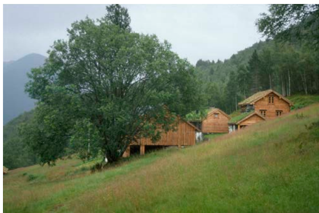
Bygninger i samspill med kulturlandskap. Ytste Skotet i Stordal. Stiftinga Sunnmøre Museum. Foto: Ragnhild Hoel © Riksantikvaren
