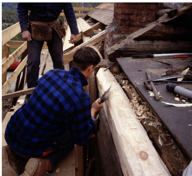
Reparasjon av raftstokk. En kopi er en kopi og ingen autentisk bygningsdel, selv om den er laget med riktige materialer og metoder. Bare bygningsdeler fra før bygningen ble innlemmet i museet, er autentiske bygningsdeler. Foto: Arve Kjerseim © Riksantikvaren
