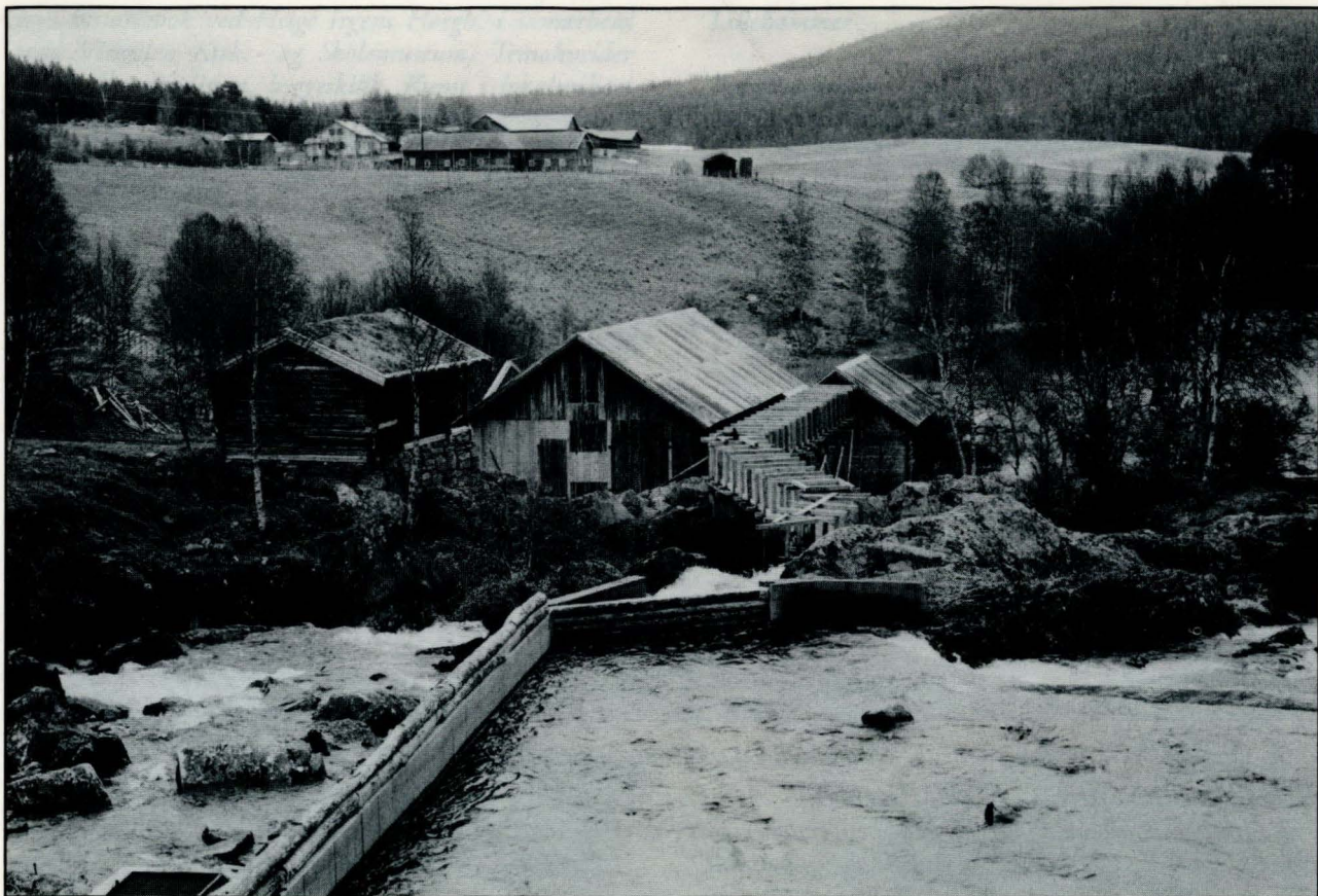
Nyrestaurert bastu, sag, turbinhus, vassrenne og deler av dam ved Atnbrua.
