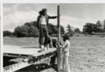
Bygging av scene til en frikonsert i Fredrikstad
