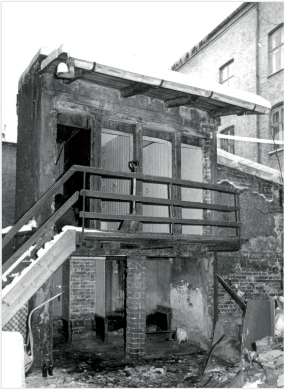
Demontering av utedoen i Smålensgate 1, Oslo. Her ser man den murte søylen i 1. etasje. Til venstre for denne ser man bakveggen med mursteinstapetet. Foto: NF, 1980.
