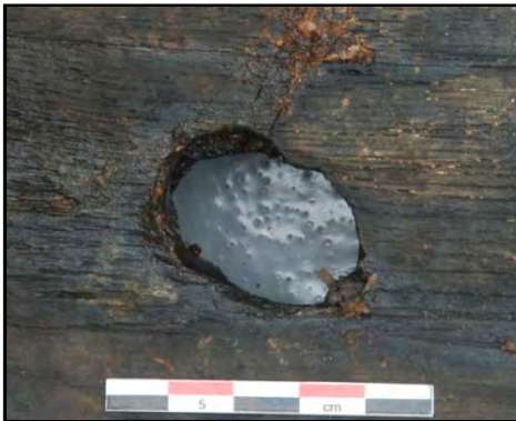
Figur 34 Hudbord x007 har et trenaglehull som var boret to ganger.
