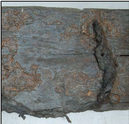
Figur 20 Utsiden av hudbord x012. Tetningsmaterial av tjære og hår forut (t.h.).
