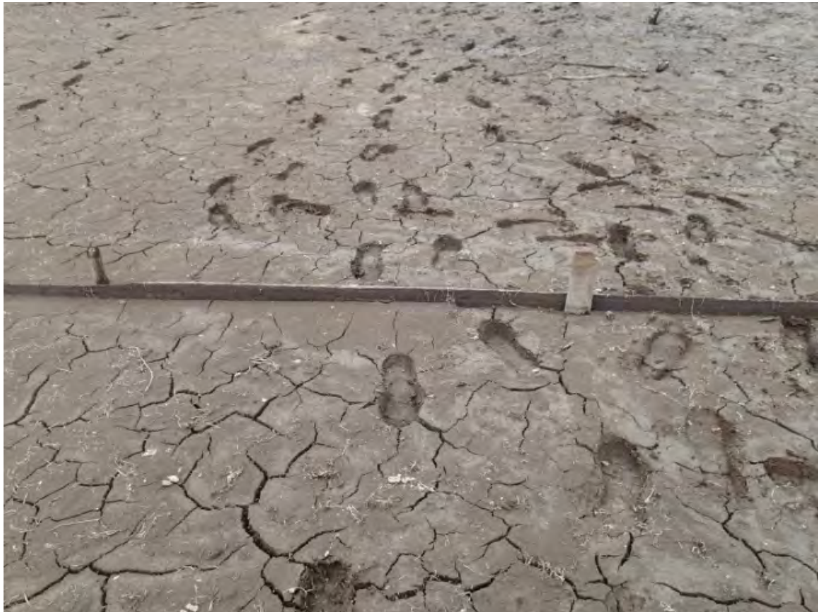
FIGUR 20 PLANKER FLETTE MELLOM PELER. KATTISE VED KATTISA
