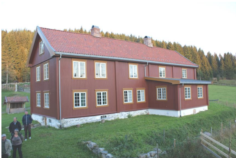
Stiftelsen UNI, Fagenhet for kulturarv, Kulturminnefondet og SMIL har støttet istandsettingsarbeidene på den tidligere Grøna skysstasjon.
