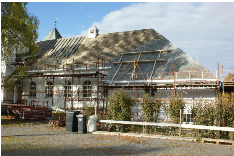
Raufoss Baptistkirke har fått tilskudd fra Kulturminnefondet til restaurering av skifertaket.
