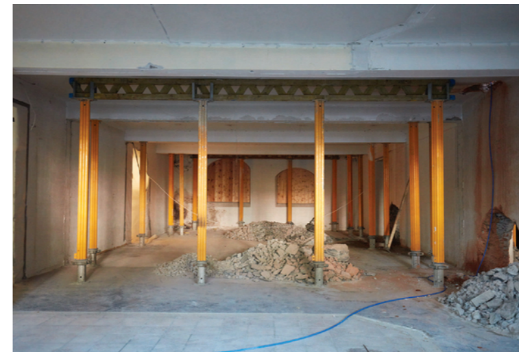
Innerst i rommet bygges den nye hovedinngangen, mars 2016.
