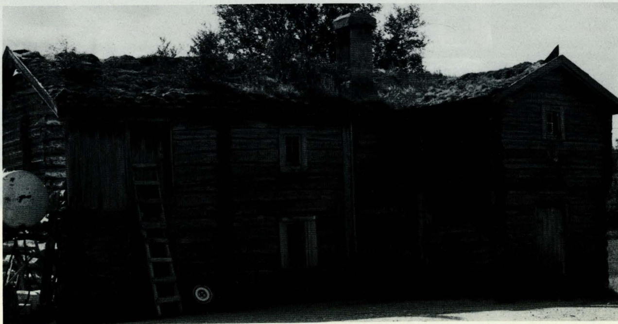
Barfrøstua på Midtdal nordre. Fasaden mot tunet. Foto: Forf. (65099)
