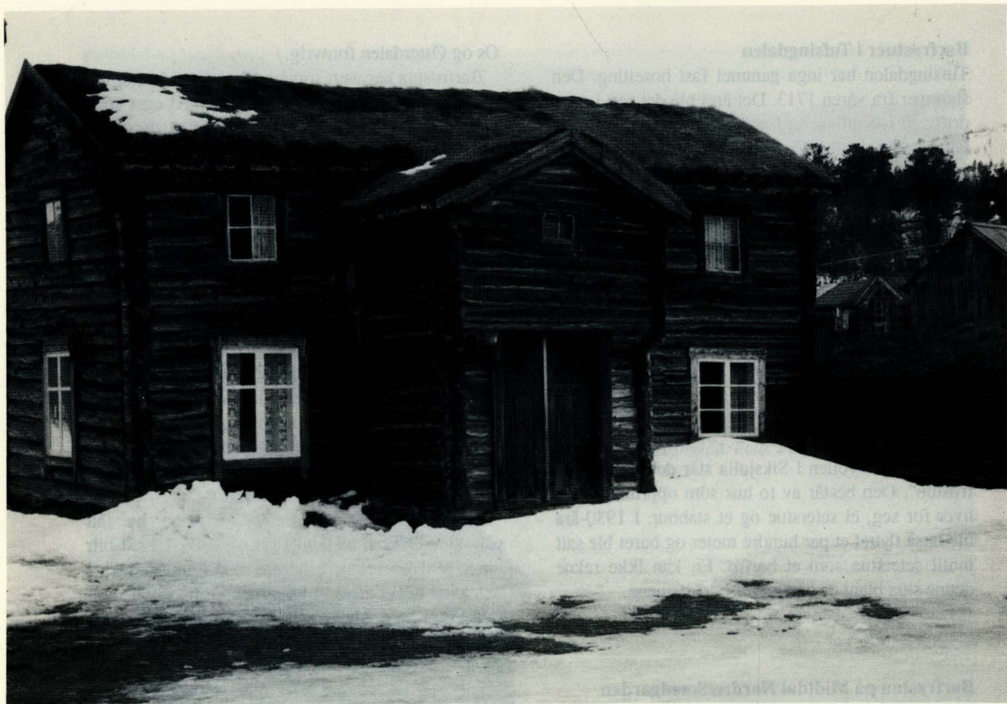
Bakken østre, i midten barfrøstua. Fasade mot tunet. Bygd før 1852. Påbygd 2. etasje mellom 1851 og 1880. Vinduene og døra i 1. etasje er skiftet ut inn på vårt århundre. T.h. hus med årstallet 1713, sannsynligvis det første våningshuset på garden. Foto: Forf. (64735).
