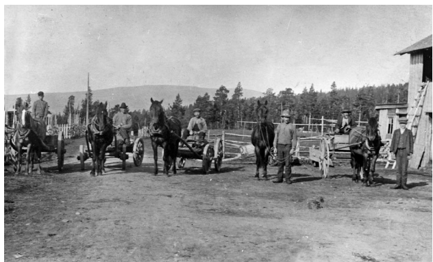
Varetransport fra Hanestad til Øvre, varene kom med tog og ble kjørt over kjølen med hest. Bildet er tatt ved Brakka, f. v. Erik E. Sørberget, junior og senior, Knut K. Vardenær, Olaus Østlund, Herman Kristoffersen, Ingvald Østlund. Brakka ble brukt som kvilested for lasskjøerne. Repro: Nordøsterdalsmuseet 25335.
