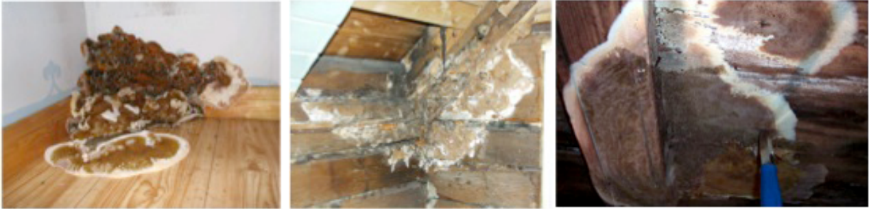
Ekte hussopp, Tømmersopp og Kjellersopp. Foto: Mycoteam
