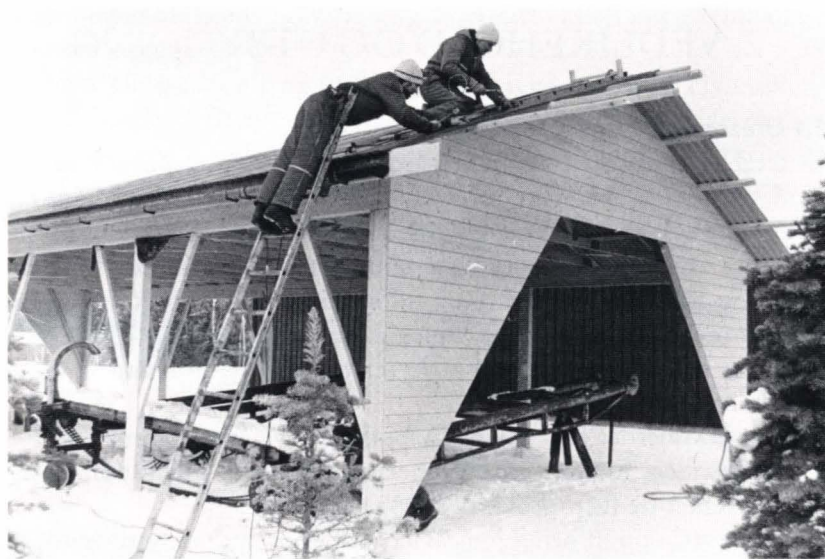
Einar Frogner og Kjell Magne Kaveldiget monterer takplatene på overbygget over barkemaskina. Foto: O.T.L.
