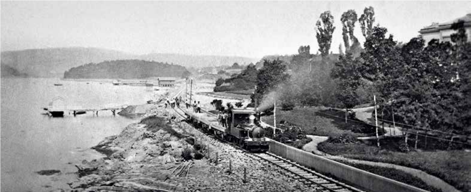
Drammensbanen mellom Skarpsno og Skillebekk. Drammensbanen ble anlagt i 1870-årene, og løkkene langs Frognerkilen ble dermed avskåret fra kontakt med sjøen. Med jernbanen skjøt også industrialiseringen fart. Skabo Jernbanevognfabrik ble etablert i Drammen. I 1873 ble produksjonen flyttet til Oslo ved Skøyen, som etter hvert ble preget av industriutbygging. På Bygdøy-siden lå derimot Smedbråten skjerm mot den raskt voksende industrialiseringen og er fortsatt en idyll med stort omkringliggende parkanlegg. Foto: Oslo Museum
