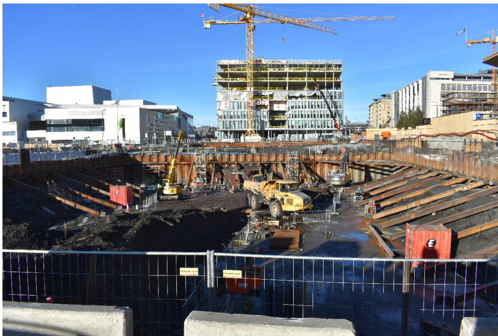
Figur 15: Oversiktsbilde over feltet hvor graving sjakktivis mellom avstiverne er igangsatt og fortløpende støping og tilhørende arbeid fører til mange aktører i felt. Foto av Marja-Liisa P. Grue, NMM.
