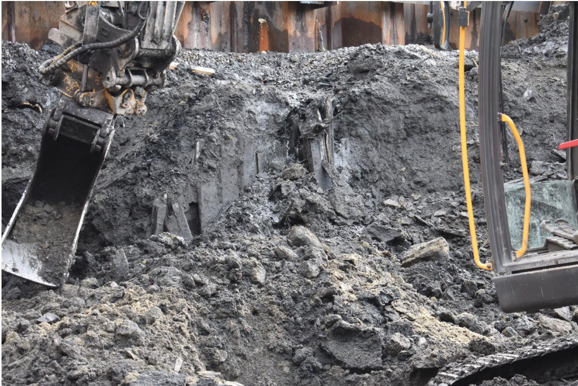
Figur 53: Del av fyllskjerm K28 med planker på høykant. Foto tatt mot S av Solveig Lyby, NMM
