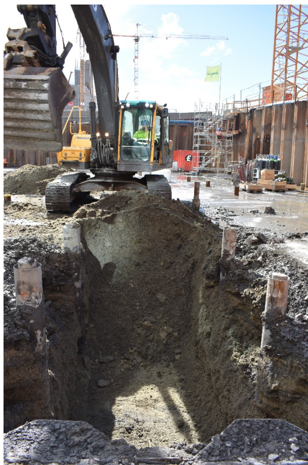
Figur 16: Graving av heissjakt i NV-del av seksjon A. Foto av Marja-Liisa P. Grue, NMM.
