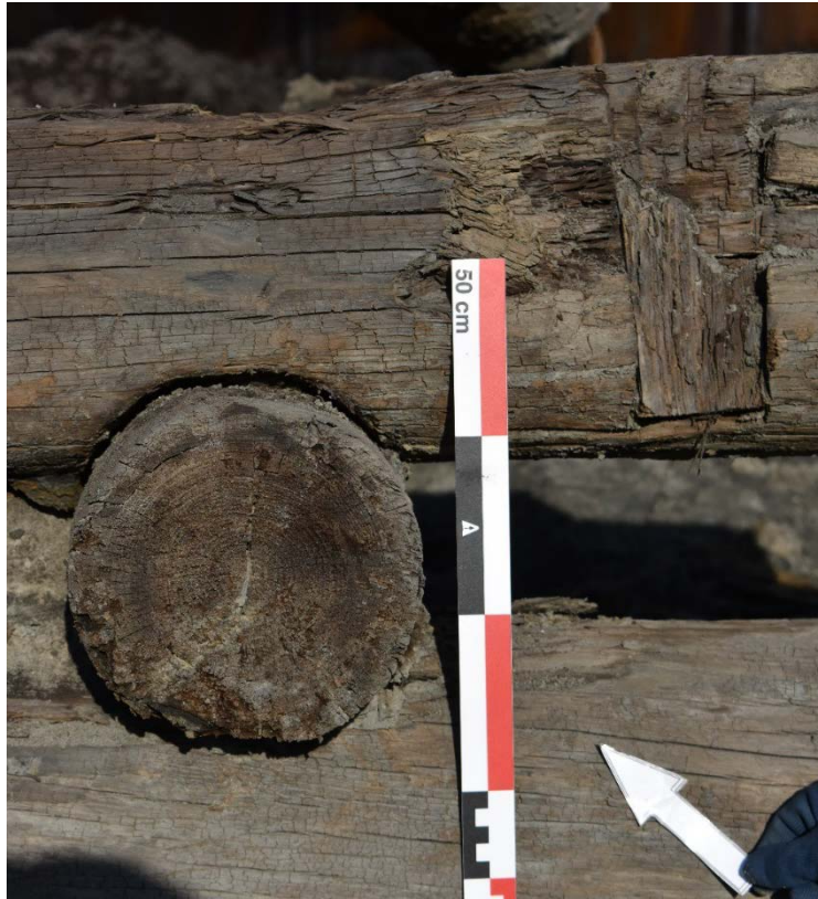
Figur 61: To stokker lafta sammen med et halvsirkelformet laft og bunnen av en rektangelformet kile brutt i øvre kant. Foto mot nord-øst av Justin Kimball, NMM
