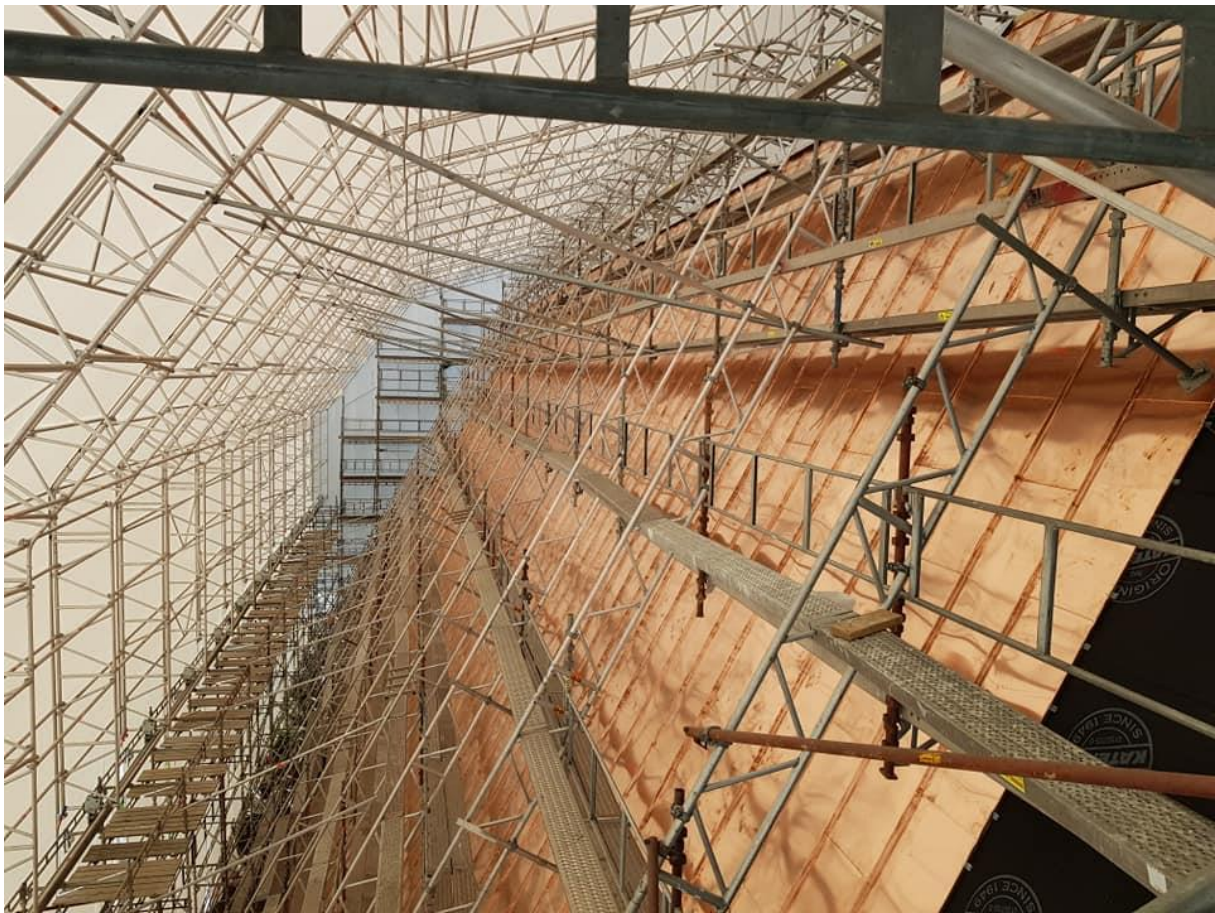
2019 ble Båthallen ferdig rehabilitert. Takarbeidene var omfattende. Blant annet ble det isolert utvendig og det ble lagt nytt kobbertak.
