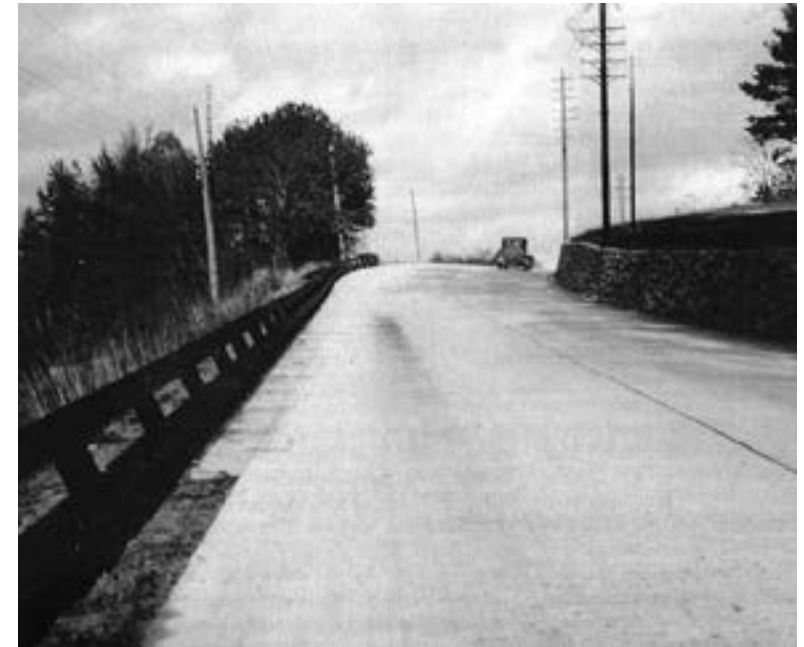
Sørlandske hovedvei ved vervingen i 1936. (Foto fra James Archers bok Vegvalg og vegskille, 1998)
