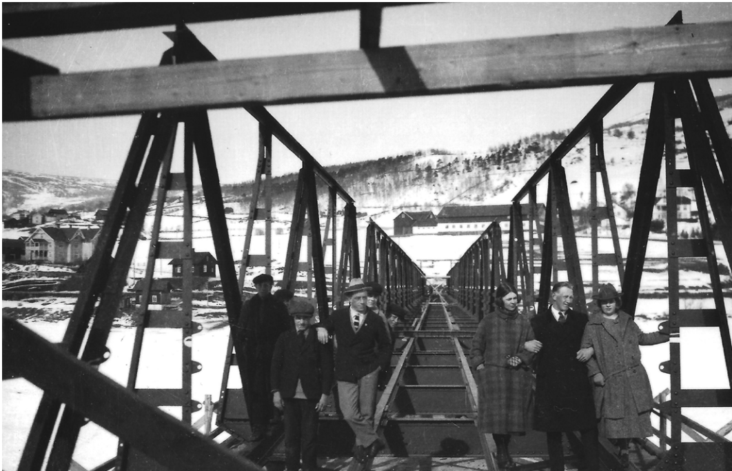
Brubygginga var ei storhending som vekte interesse i lokalbefolkninga. Under ser vi nokre på ein uofisiell inspeksjon våren 1924. Det er stille på brua og dei nysgjerrige er ikkje kvardagskledd, så kanskje var det ein søndag. (Foto frå Ole Kristian Kvernes)
