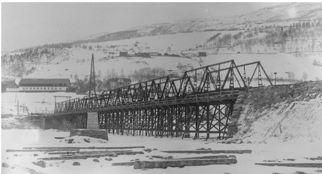
Vinteren 1924 er stålkonstruksjonen kome på plass. (Foto frå Maihaugen)
