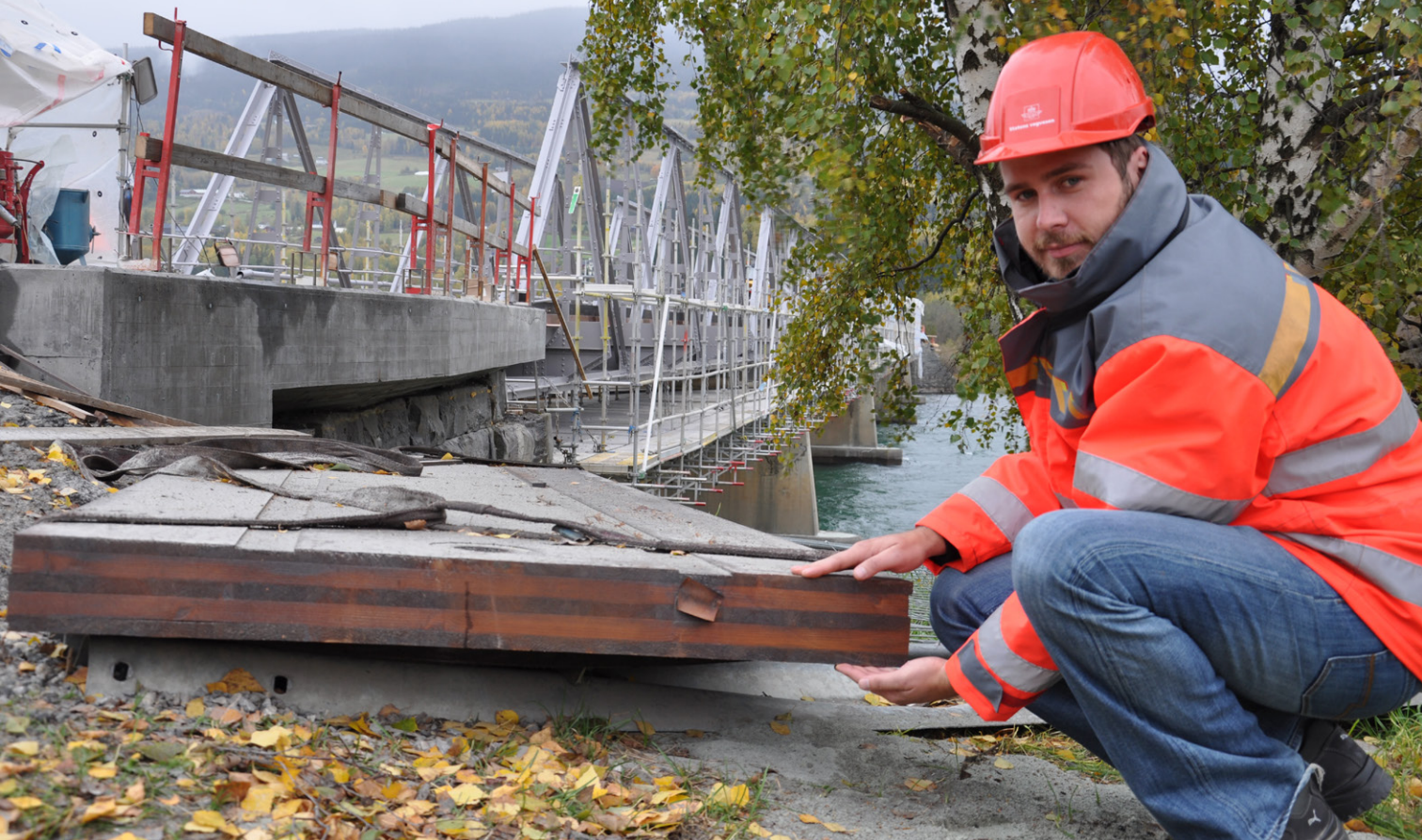
Byggeleiar Anders Brenne syner fram tre-elementa som vart lagt som nytt dekke på brua i 2010. (Foto: Håkon Aurlien)
