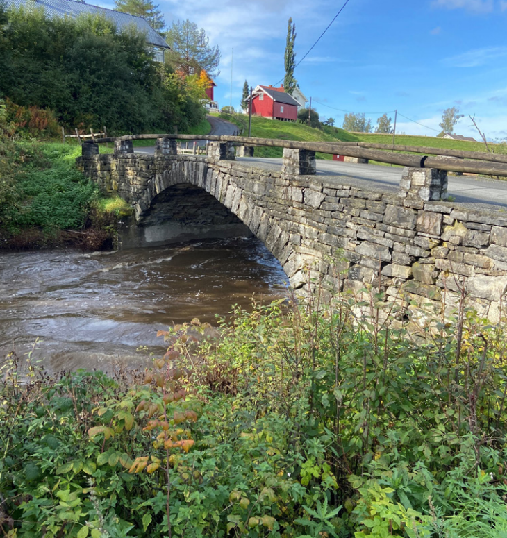
Håjen bru i Østre Toten, Innlandet, en steinhvelvbru fra 1861 der kommunen nå jobber med å sette opp skilt og skifte rekkverk. Vi er inne som rådgivere. (Foto: Cathrine Thorstensen)
