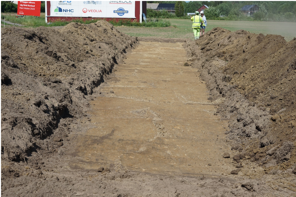
Fig. 26. Schakt area 84, foto från S.
