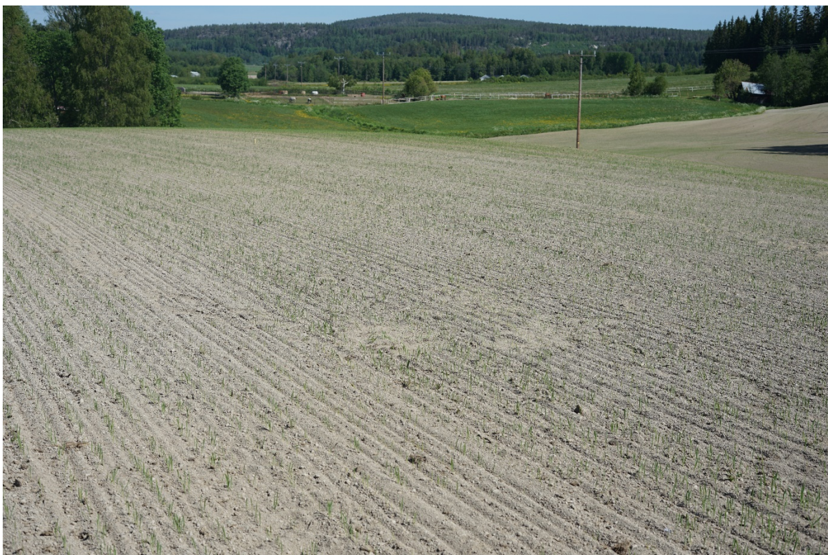
Fig. 23. Yta 19 innan schaktning. Foto från SSV.
