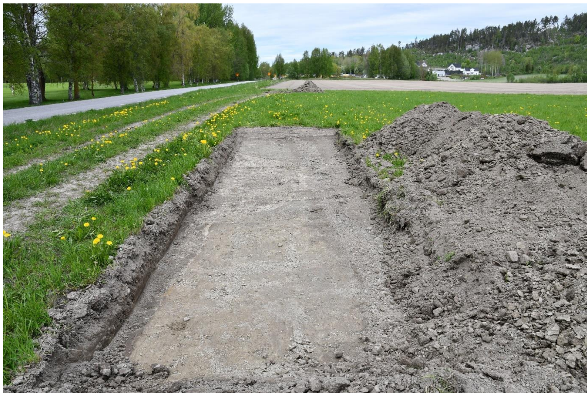
Figur 6. Schakt 2, foto från söder.
