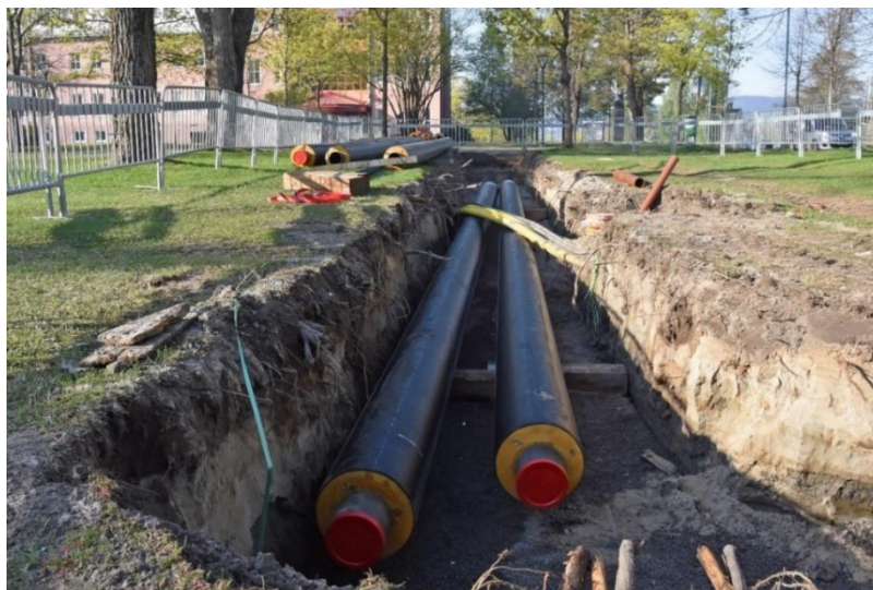
Figur 4. Schakt 3 parallellt med Brunnshusgatan.
