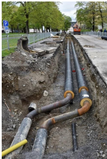
Figur 3. Schakt 1 längs Trädgårdsgatan.
