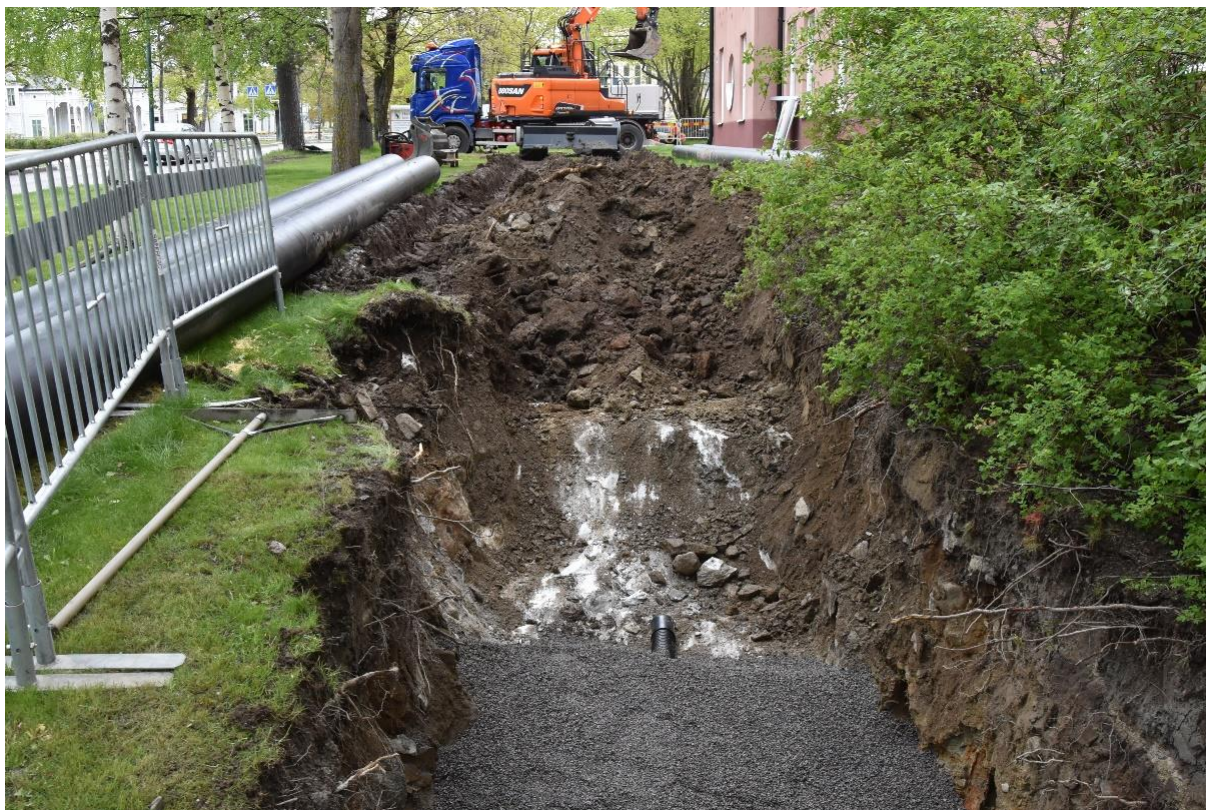
Figur 7. Berg i schakt 4.
