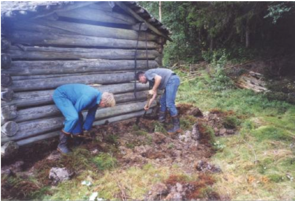
En åtgärd som är enkel att utföra är att gräva rent kring grunden. Björsjöbodarna, Haverö (Harry Walker, 2001)
