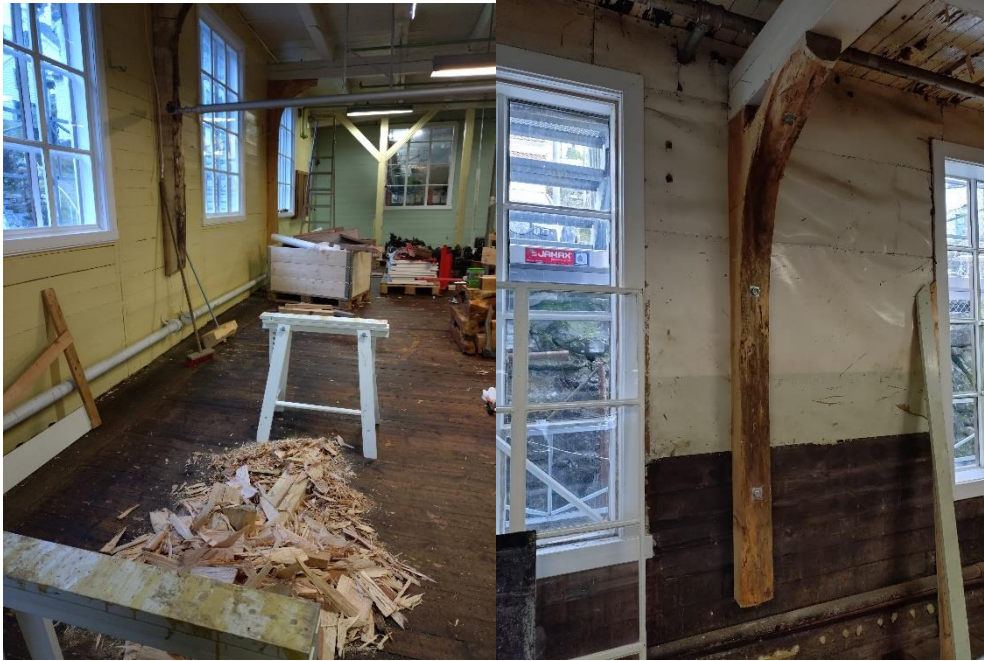
Foto: Bjørnar Myklebust. Bilete viser montering av nye rotkne i 1900-bygget.
