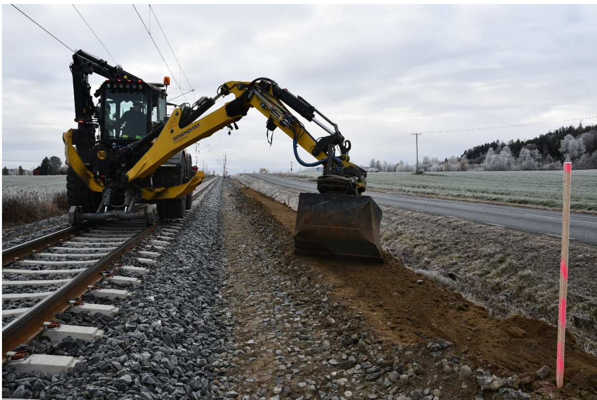
Utrengade massor från rälsbytet planas till.
