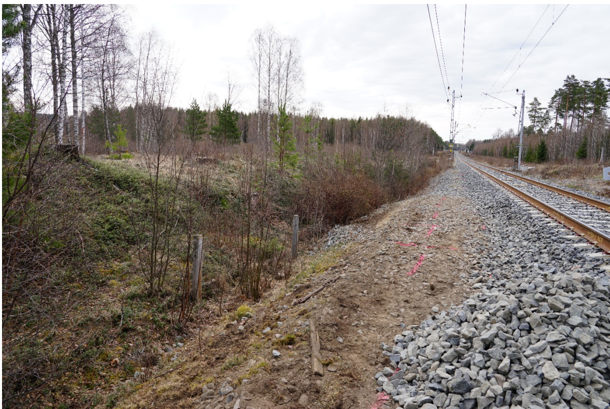
Fig. 17. Översiktsbild innan schakt 14. Pukeborg till vänster i bild. Foto mot S.
