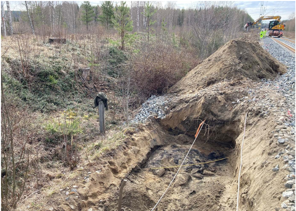
Fig. 3. Gropen med kol i södra delen av schaktet. Pukeborgs mellersta kulle till vänster i bild. Foto från norr.
