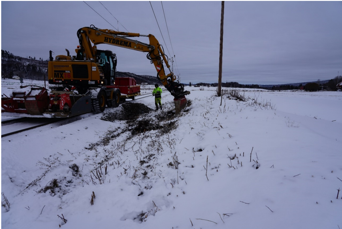
Fig. 14. Översiktsbild vid schakt 8. Foto mot N.
