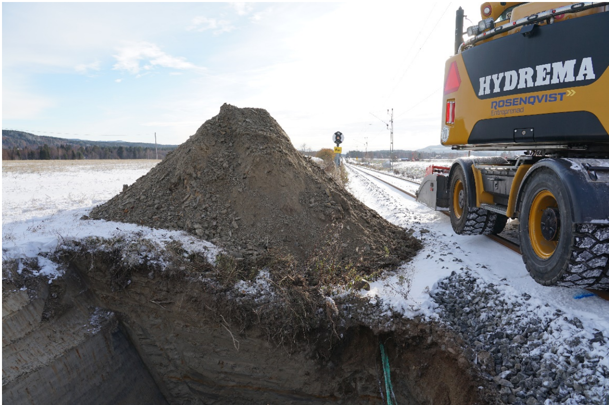
Fig. 10. Översikt - arbetsbild vid schakt 7, Hjärtnäs. Foto mot S.
