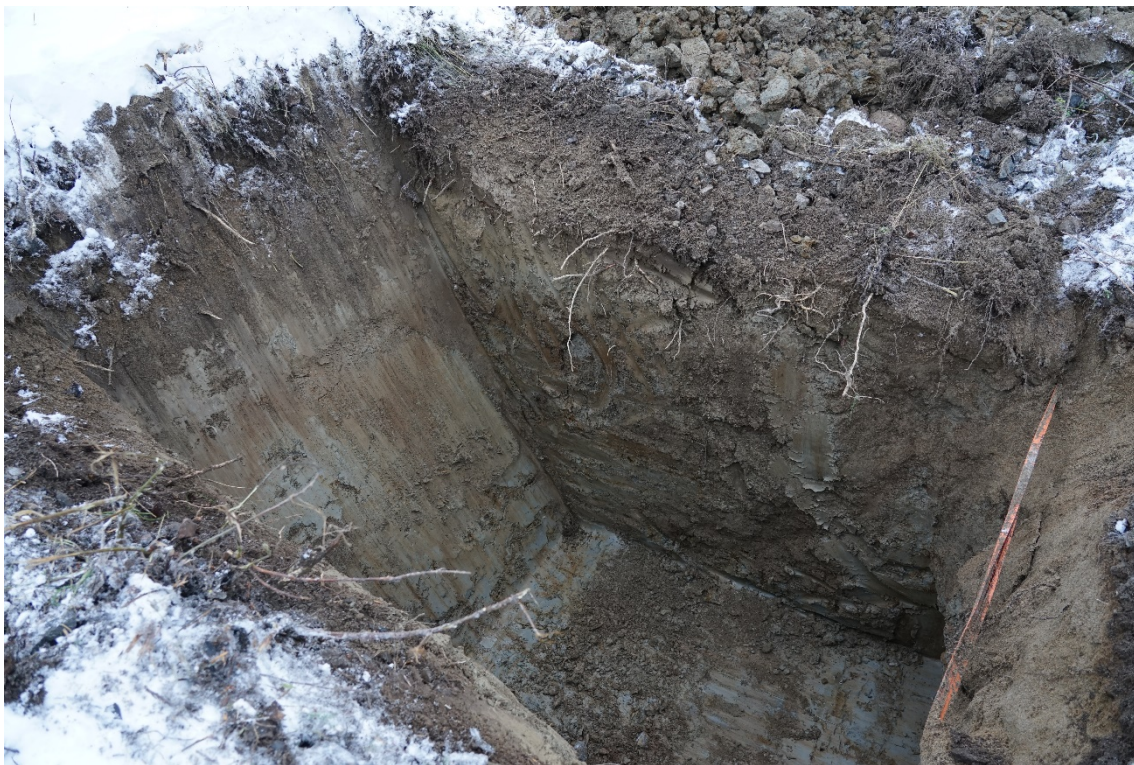
Fig. 15. Schakt 8. Foto mot SV.
