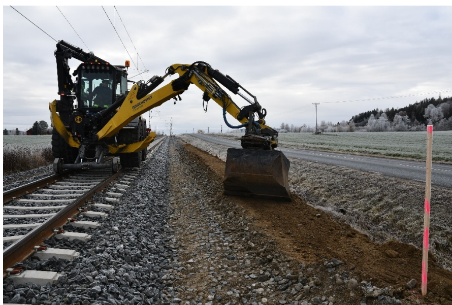
Fig. 4. Utjämning av spårballast 2022.
