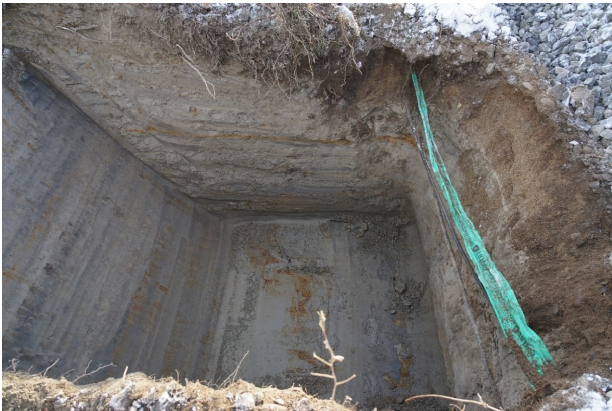
Fig. 11. Schakt 7. Plasten till höger är band till en ledning. Foto mot S.
