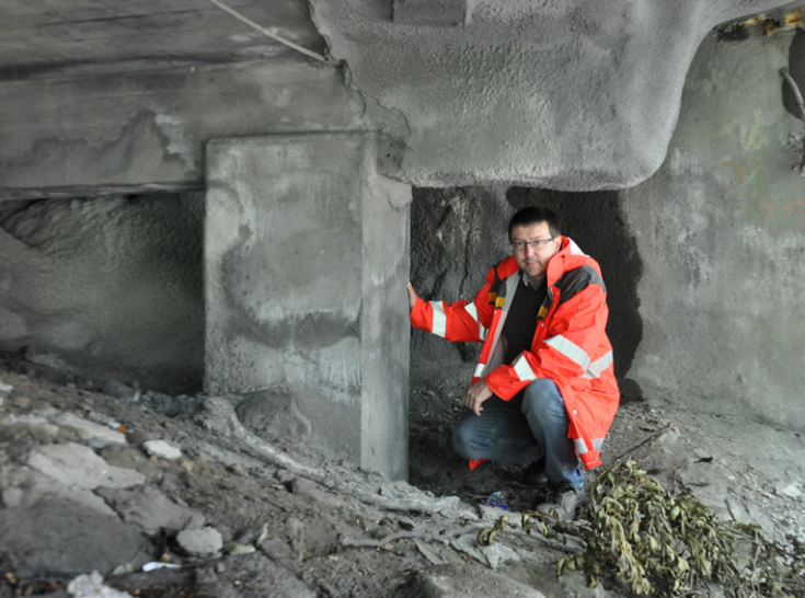
Bruingeniør Ian Willoughby var i 2016 byggeleder for en grundig ti-års vedlikeholdsjobb på bruforbindelsen. Her er han under viadukten der gammel betong ble tatt bort og erstattet med ny armering og ny betong. (Foto: Håkon Aurlien)
