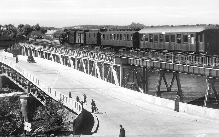
Sarpsbrua ombygd i 1936. I 1943 var den reparert til samme utseende. Siden har den vært uendret, om en ser bort ifra rekkverkene. Såvel bilene som togmateriellet har hatt en rivende utvikling. (Foto fra Norman
